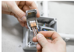
Verdrahtete Klemme in die Gelbox einlegen.
